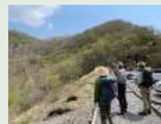
現地調査状況
