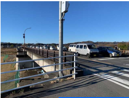
事業前の状況（町屋橋付近）
