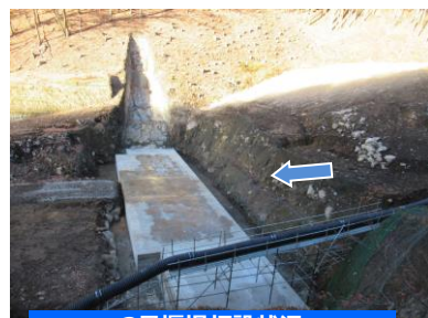
3号堰堤打設状況
