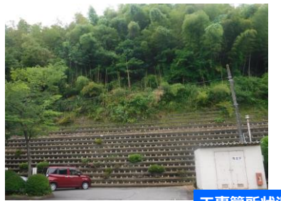
工事箇所状況
