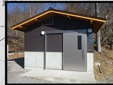
赤城神社裏公衆トイレ (多目的トイレ)
