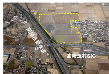
〔高崎玉村スマートIC北地区工業団地〕
