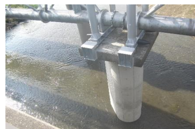
〔東毛工業用水道水管橋耐震化〕
