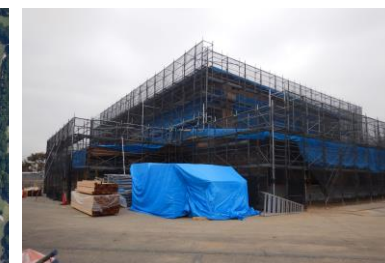
〔板倉ゴルフ場クラブハウス建替工事〕
