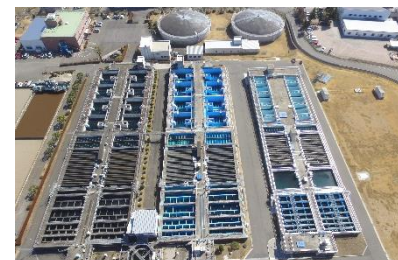
〔県央第一水道浄水場〕
