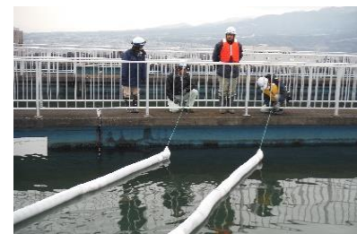
〔技術研修（油吸着資材設置）〕
