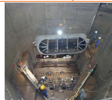
〔白沢発電所リニューアル工事〕
