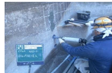
〔渋川工業用水道沈殿池補強〕
