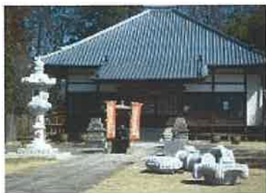
①石塔が倒れた光恩寺
