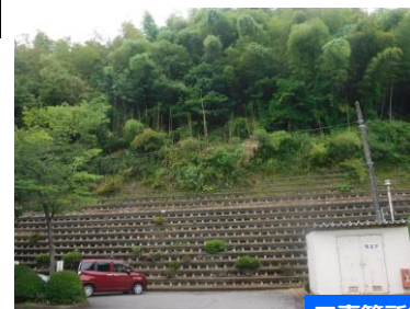
工事箇所状況
