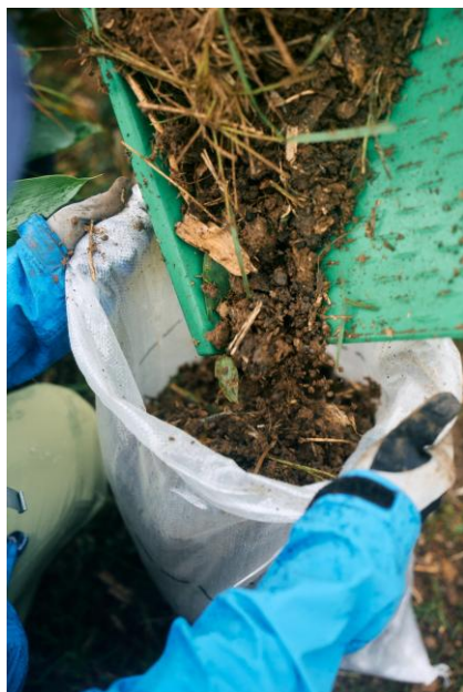
側溝から掘り出した土砂は土のう袋に入れる。 笹の根を含む土砂や、泥状になった土砂、石が多い土砂など中身によって袋を分けると使いやすい。
