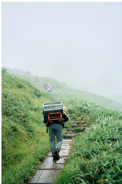
背負子で土のう袋を歩荷。 雨に濡れた土は非常に重い。
