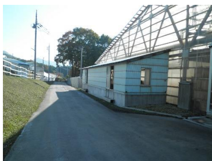
密閉型堆肥舎に設置
