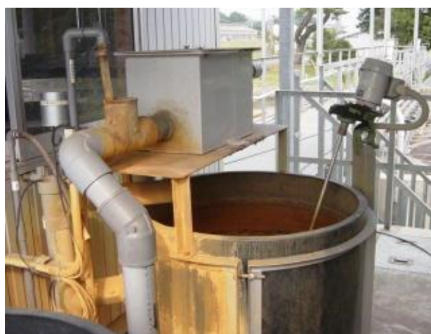
ポリ硫酸第二鉄添加高度処理装置
