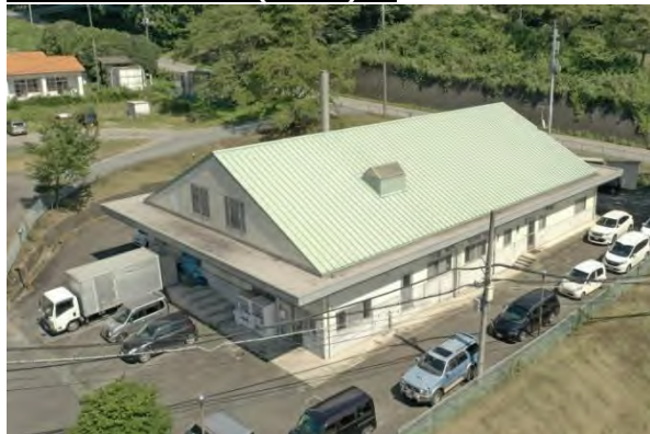
要配慮者利用施設(管理棟)
