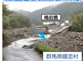
豪雨による落橋及び道路崩壊
