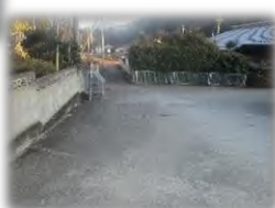
避難経路（町道）
