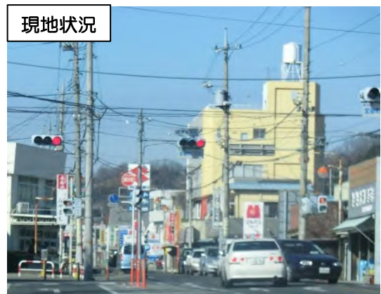
乱立する電柱・電線類
