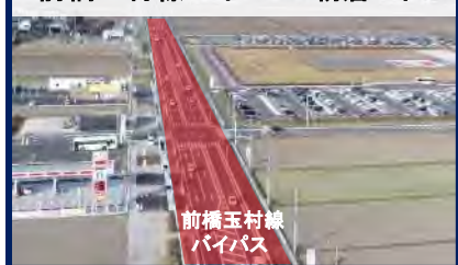
前橋玉村線バイパス 朝倉工区
