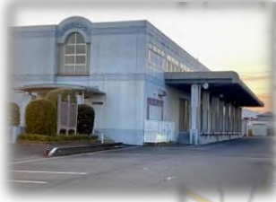
群馬県地域防災センター （大規模災害時の防災拠点）
