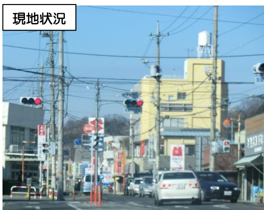
乱立する電柱・電線類
