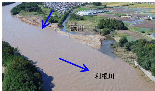
図－2.3 令和元年 10 月 13 日 台風 19 号 (利根川出水状況)
