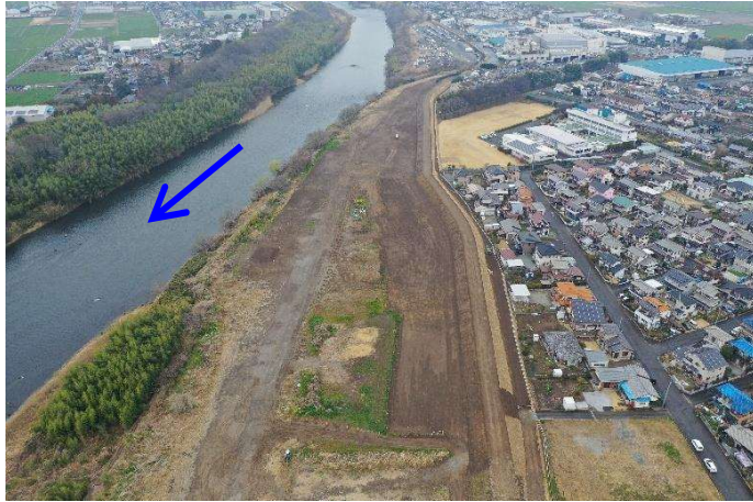
図－2.4 利根川・佐波郡玉村町樋 ひ
