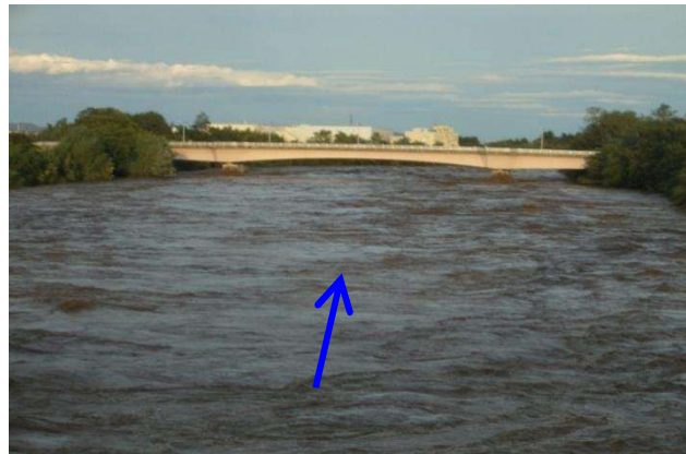
図－2.2 平成 25 年 9 月 16 日 台風 18 号 (利根川【玉村大橋上流】出水状況)
