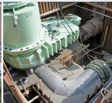
老朽管の布設替え工事（渋川工業用水道）
