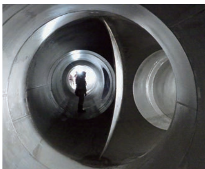
水圧管路内部
