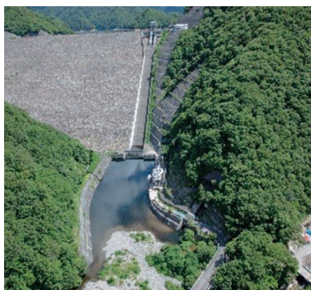
奈良俣発電所と奈良俣ダム
