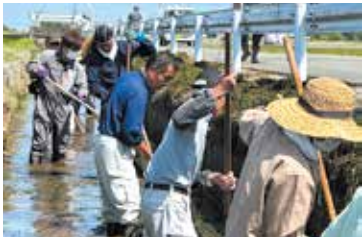
水路の泥上げ作業の様子
