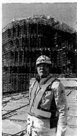
北野牧トンネルの工事現場にて
