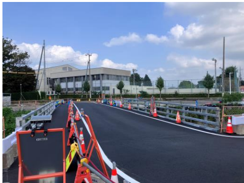
御蔵橋工事写真 (仮設橋設置)
