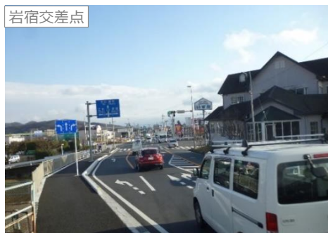
事業後の状況(一部完了区間)
