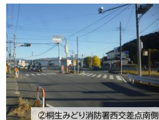
②桐生みどり消防署西交差点南側
