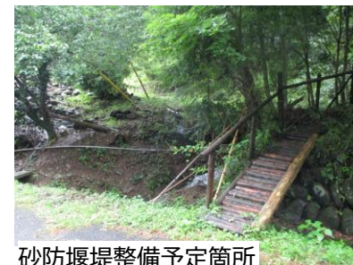
砂防堰堤整備予定箇所
