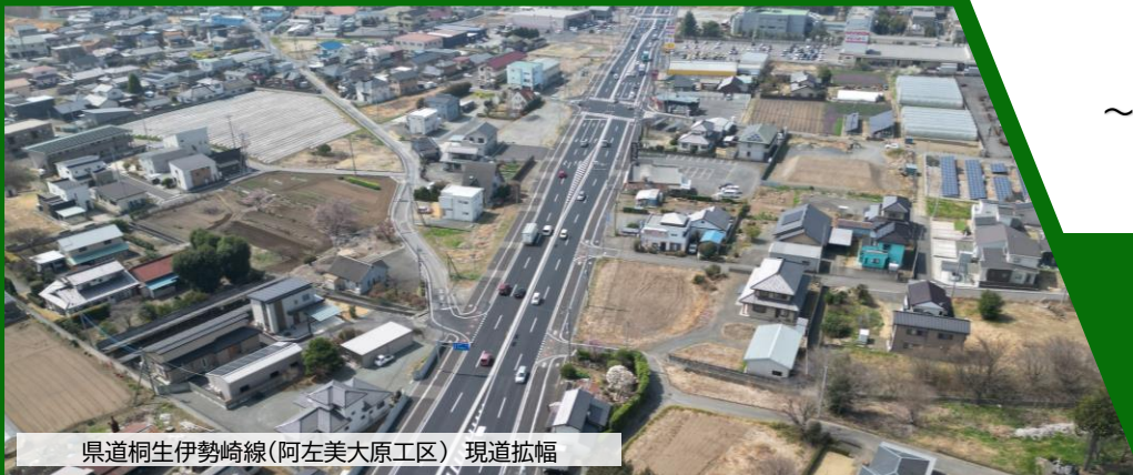
県道桐生田沼線(本町工区) 電線共同溝
