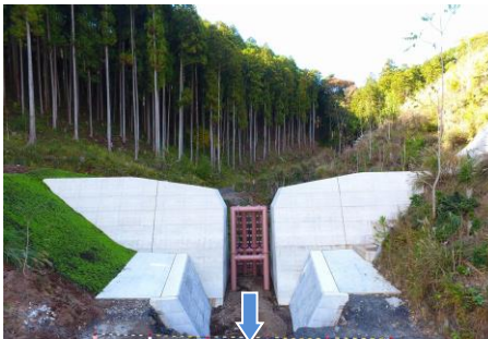
堰堤の完成状況
