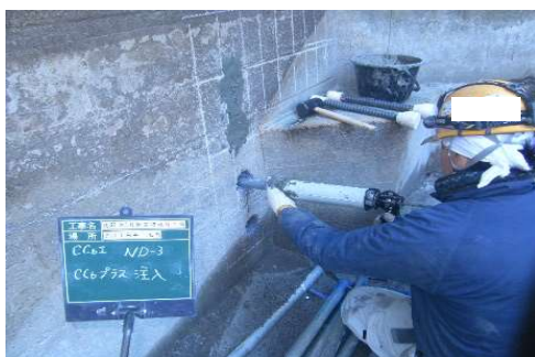
〔渋川工業用水道沈澱池*補強〕
