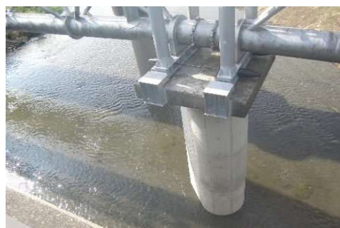
〔東毛工業用水道水管橋*耐震化〕
