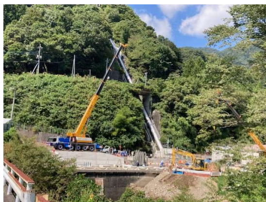
〔四万発電所 水圧鉄管（更新後）と発電所（工事中）〕
