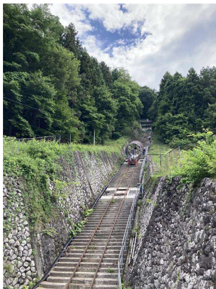
〔白沢発電所 水圧鉄管の据付〕
