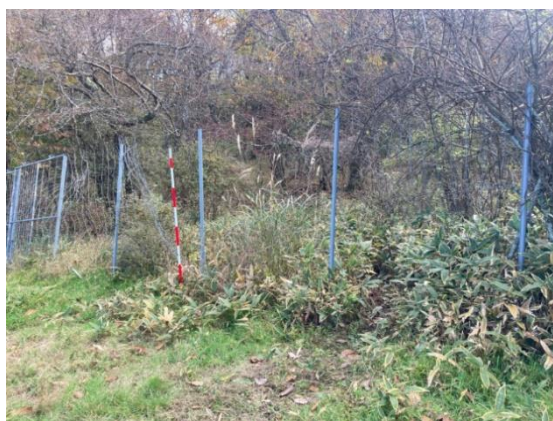
金網柵の設置状況
