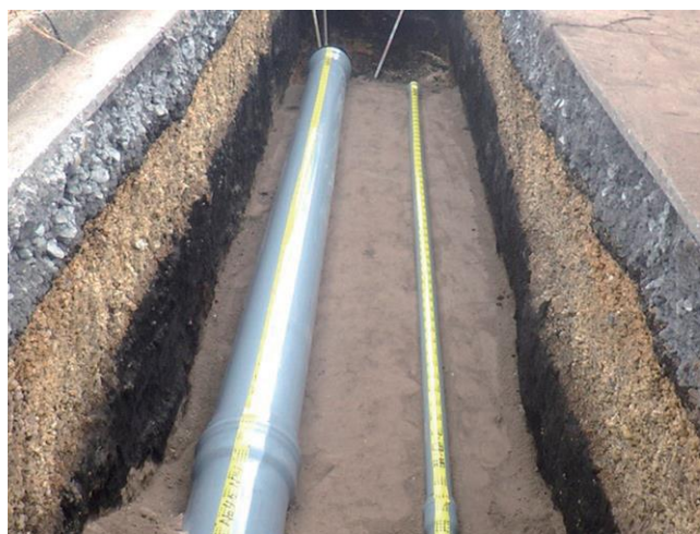
塩ビ管による敷設替え状況（昭和村）
