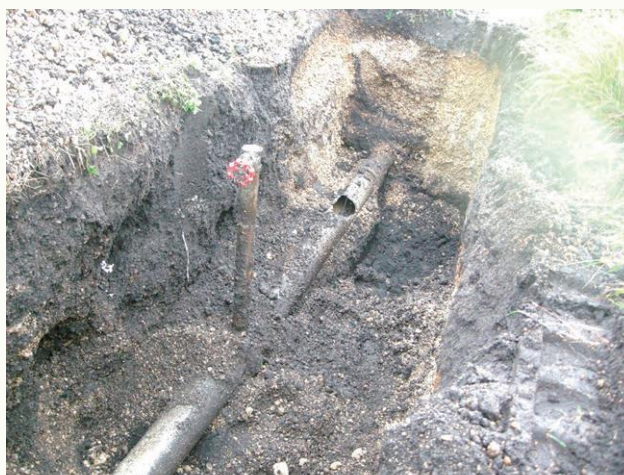
石綿セメント管の破損状況（昭和村）
