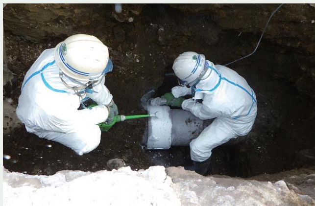
石綿(アスベスト)を含む農業用管水路を撤去し、硬質塩化ビニル管へ更新
