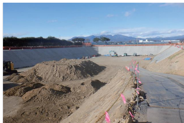
湛水被害を未然に防ぐ調整池の造成状況（太田市：藪塚西部地区）
