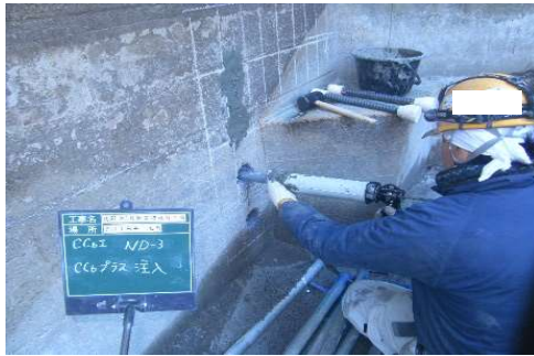
〔渋川工業用水道沈澱池*補強〕
