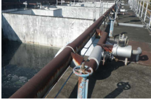
〔老朽化した1系2系浄水処理施設〕
