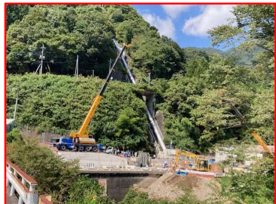
〔四万発電所 水圧鉄管（更新後）と発電所（工事中）〕
