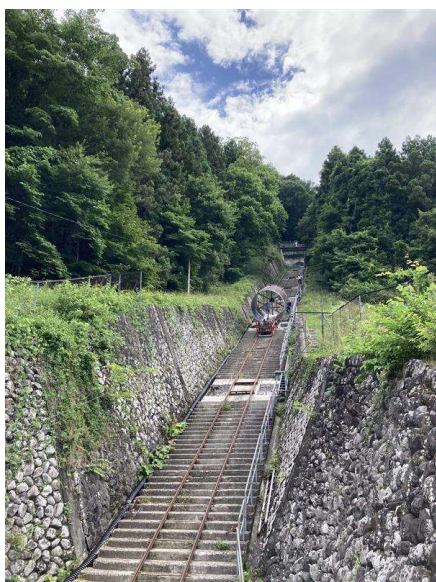
〔白沢発電所 水圧鉄管の据付〕
