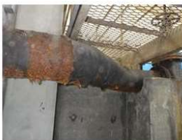
老朽化した送水ポンプ室内配管
