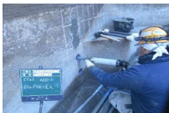
渋川工業用水道沈殿池補強
