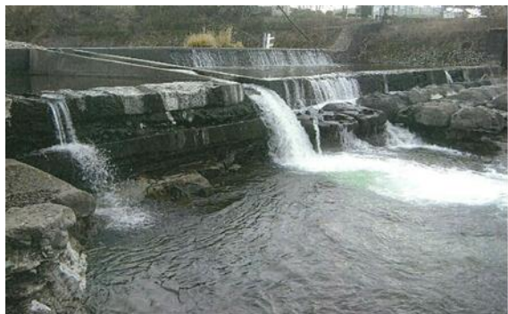
写真3 移動障害のある取水堰
