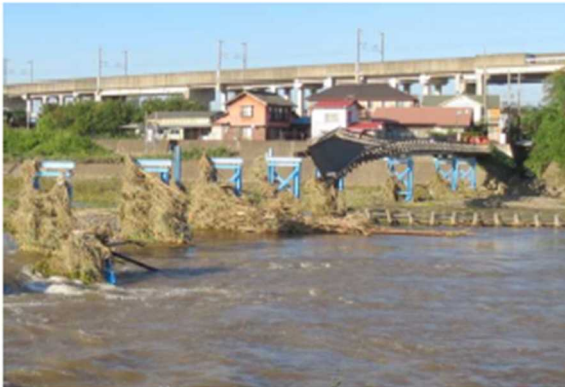
台風により被災し流出した佐野橋
