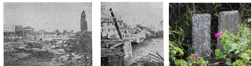
桐生市境野町地内（家屋倒壊）※ 桐生市目抜き通り（家屋倒壊・橋梁流失）※ カスリーン台風伝承碑（桐生川広見橋右岸）
