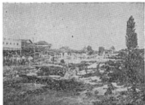
桐生市境野町地内（家屋倒壊）※
