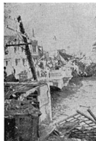
桐生市目抜き通り （家屋倒壊・橋梁流失）※
