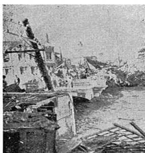
桐生市目抜き通り （家屋倒壊・橋梁流失）※
