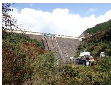
図-2.3 草木ダム (東発電所・東第二発電所)
