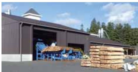
▲ 県産木材の製材置き場
