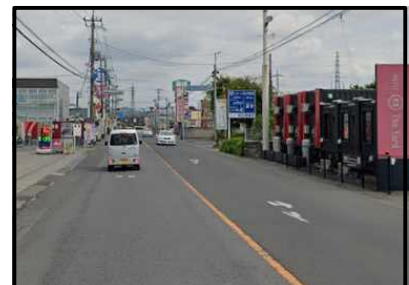
③ 歩道未整備箇所(国道122号)
