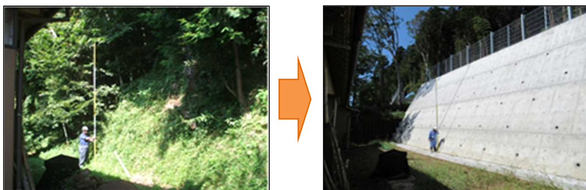
写真 急傾斜地崩壊防止施設の整備による土砂災害警戒区域等の見直し箇所例
