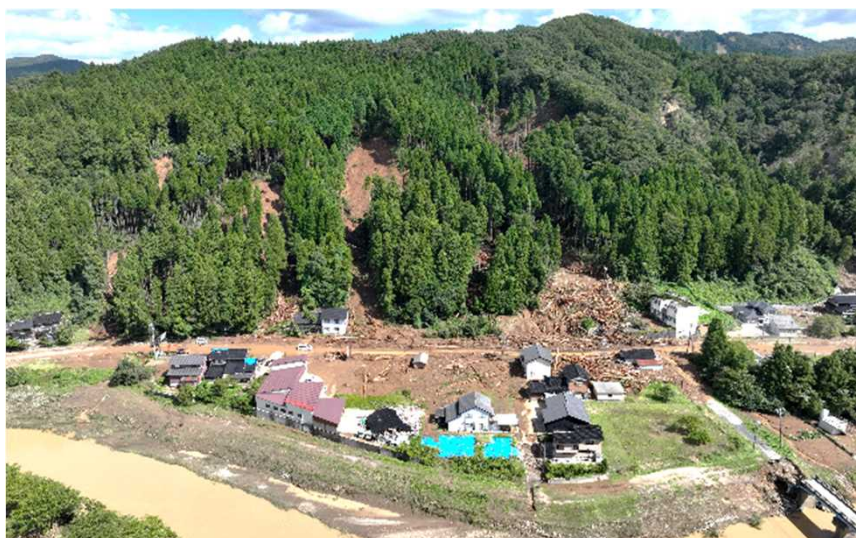
写真 輪島市で発生した土砂災害（奥能登豪雨）
