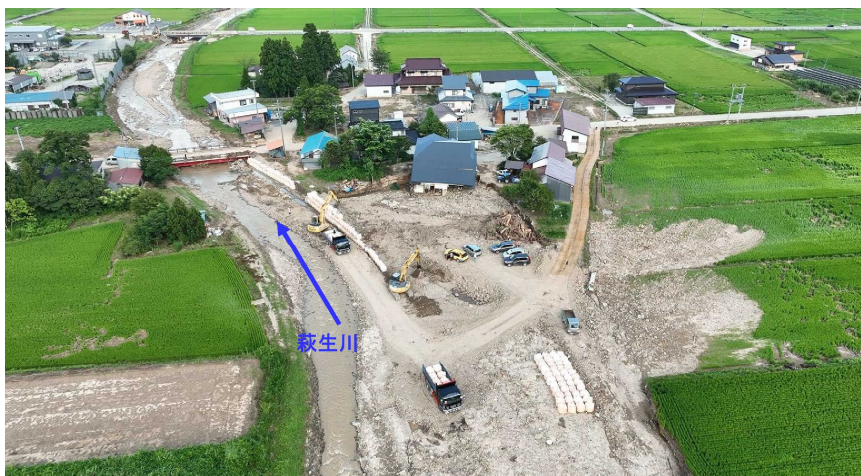
写真 令和4年8月に山形県西置賜郡飯豊町の萩生川で発生した土砂・洪水氾濫 出典：国土交通省資料
