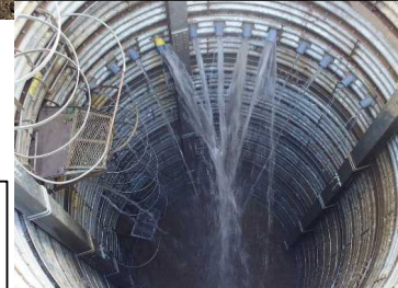
対策効果：集水井内部の状況（令和元年東日本台風時）
