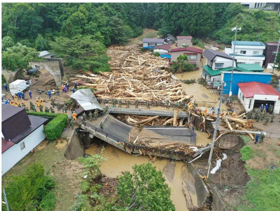
写真 流木による河道の閉塞
