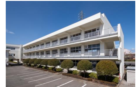
改修工事を行った県立学校
