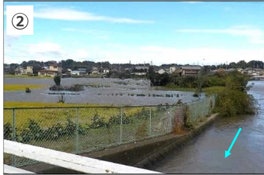
新谷田川放水路沿川の浸水状況
