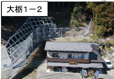
崩壊土砂防護柵工・法枠工 (R5完成済)
