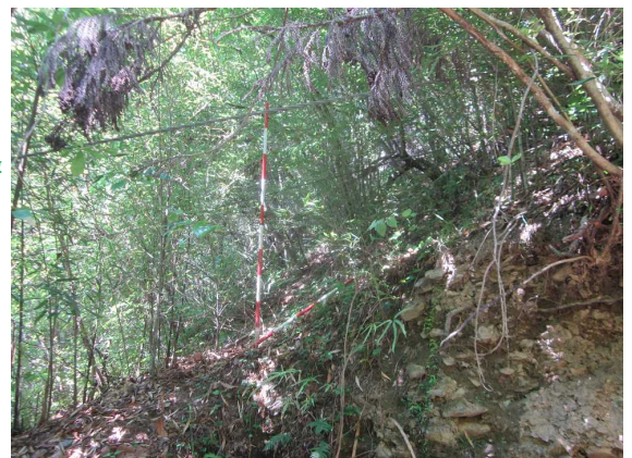
急勾配の斜面状況
