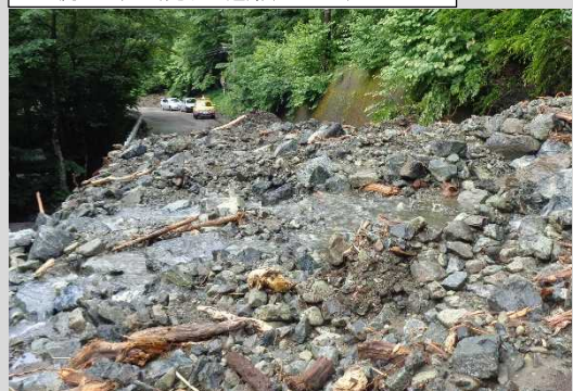
土石流により寸断された道路(イメージ)
