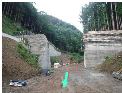
1号堰堤 (施工中)
