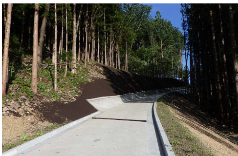
町道付替工 (施工済箇所)
