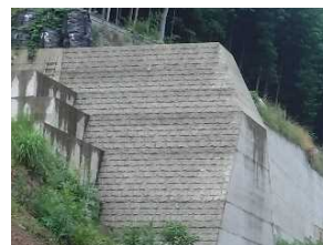
←化粧型枠 (1号堰堤施工済み部)
