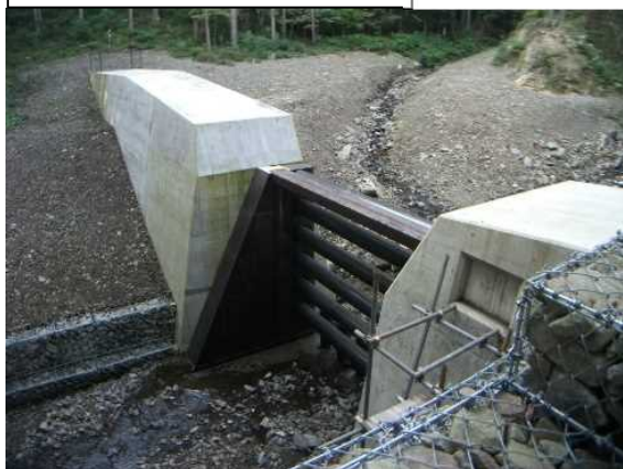
堰堤整備による効果(イメージ) 堰堤整備により、土石流と流木を捕捉
