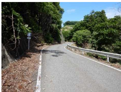
B 区間開設状況
