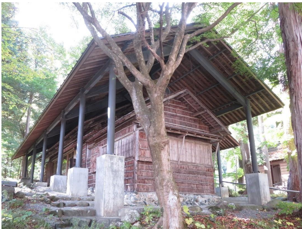
廣池千九郎谷川記念館麗澤館 (旧主屋及び旧浴場) 外観①
