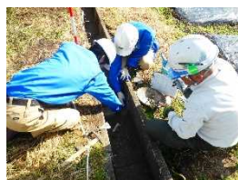
水路簡易補修
