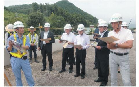
工事の進捗状況について説明を受ける様子
