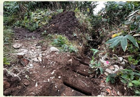
ひとつひとつの側溝にたまった土砂を掘り出し、水の流れ道をつくります！毎年つづけていく活動になります。
