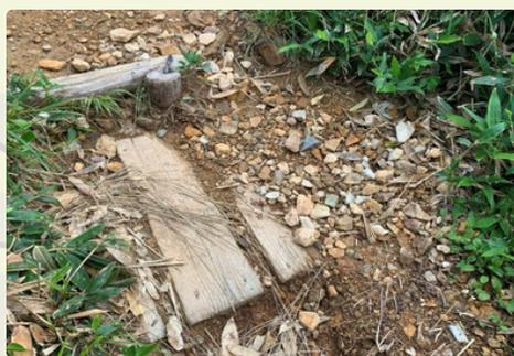
雨水が登山道に流出しないよう山頂への登山道に36カ所側溝が設けてあるが土や石が詰まり機能していない状況…
