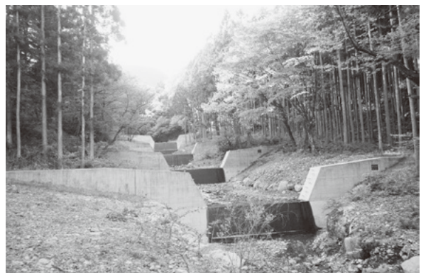
土砂流出の抑制のため施工された治山ダム工
