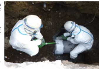
富士見地区 【石綿管撤去状況】
