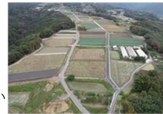
笠張地区 【区画整理工事完了】
