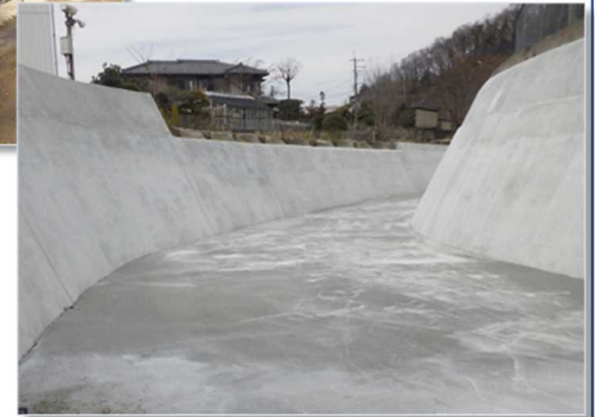
対策工実施後
