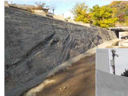
対策工実施前
