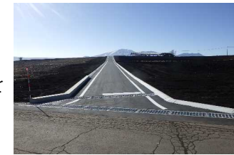
仙之入地区 【完成した農道】
