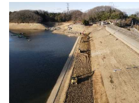
大谷池 【堤体上流側耐震補強 工事施工状況】
