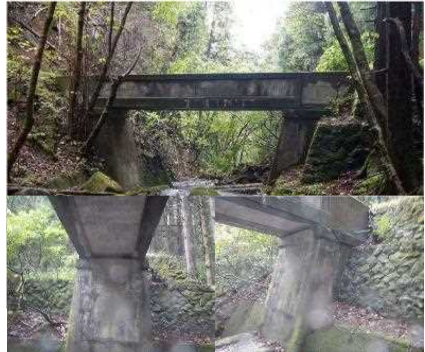
改修前の掛樋
