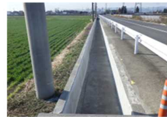
佐波新田用水第 1 地区 【改修後の水路】
