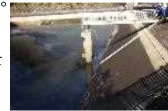
広場貯水池 【劣化状況調査】
