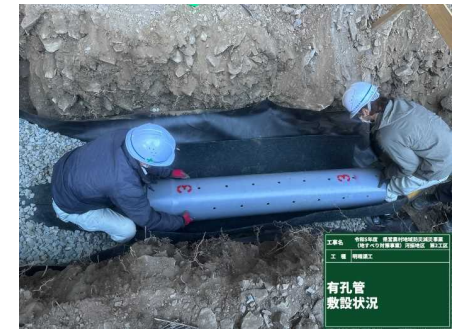
明暗渠工及びカゴ枠工
