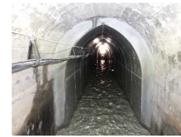
追貝平 1 期地区 【隧道補修工事】
