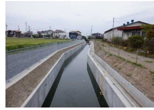
藤川用水2期地区 【対策工事実施】
