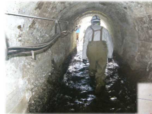
補修工事前 (定点監視)
