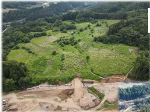
区画整理工事前 (上空から)
