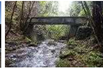
美野原 3 期地区 【改修前の状況】
