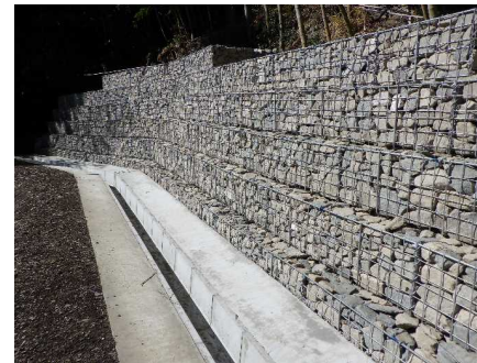
明暗渠工及びカゴ枠工
