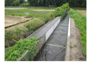
神流川用水地区 【既設水路改修後】
