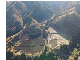
牛の平地区 【区画整理工事実施状況】
