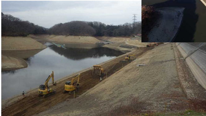
上流側堤体の盛土状況
