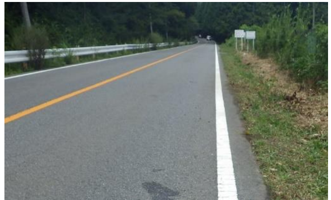
道路の除草状況（前橋赤城線）
