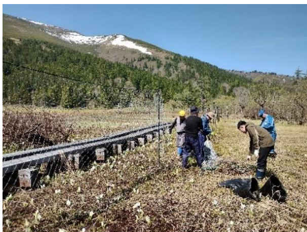
植生保護柵設置の様子
