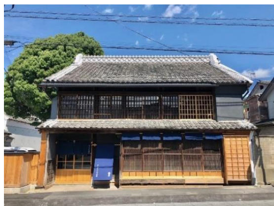
桐生市重伝建地区公開活用施設 （まちなか交流館）（画像提供：桐生市）
