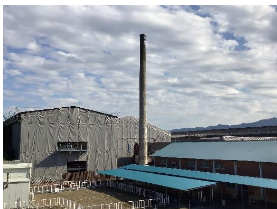
富岡製糸場煙突（画像提供：富岡市）
