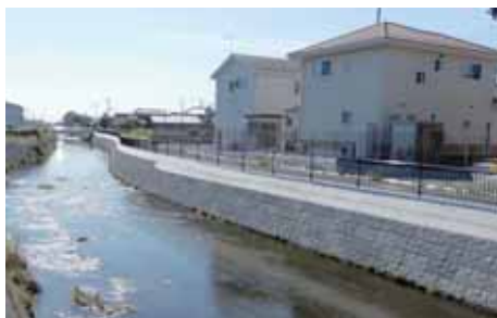
▲ 一級河川大川の河川改修
