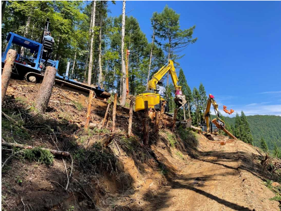
急傾斜地に応じた作業システム
