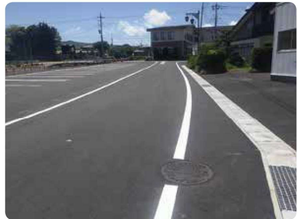
村道改良工事(孺恋村)
