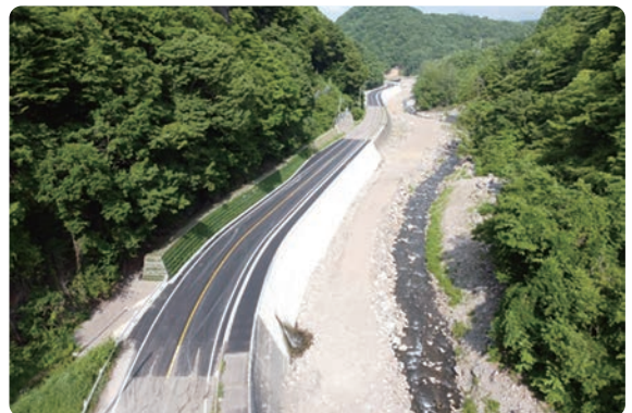
令和元年東日本台風災害復旧（国道144号）
