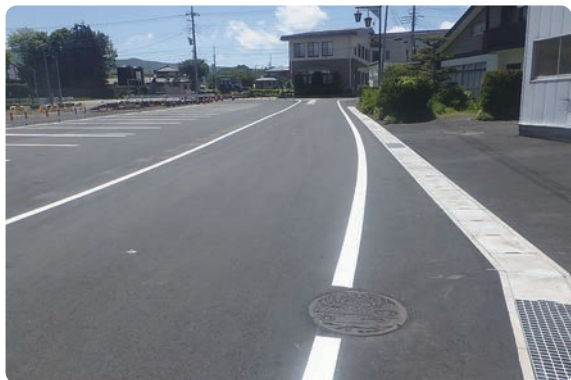
村道改良工事(婦恋村)
